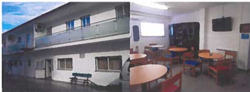
Figura11: Pavilhão I – Fachada e Sala Convívio Trabalhadores
