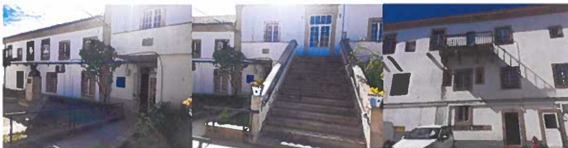
Figura 4: Pavilhão A - vista do 1.º andar – quartos e Entrada Salão Nobre e vista geral
