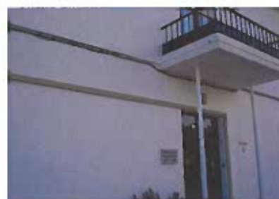
Pavilhão C - SEDE
