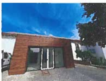
Pavilhão B - SEDE
