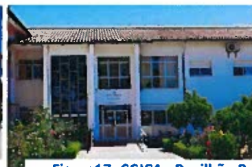
Figura17: CCJCA - Pavilhão B
