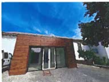
Pavilhão B – SEDE
