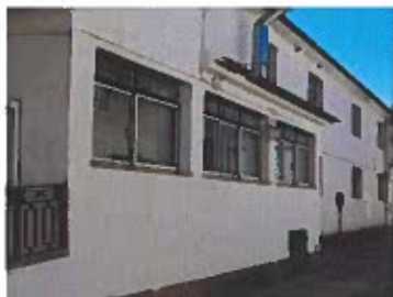
Pavilhão H - SEDE
