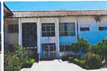
Figura 17: CCJCA - Pavilhão B
