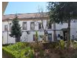
Figura 6: Pavilhão A - vista do 1.º andar - quartos
